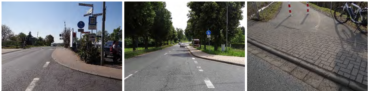
Zu schmale Absenkung bei 2-Richtungsverkehr
